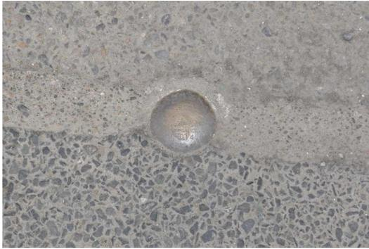
分かりにくいですが、前項で紹介した杭と対面する場所（千葉銀行のATM前を通る小道のところ）に敷設されていたもので、「道路台帳基準点3級N0-014国土交通省」と記されていたものである。
